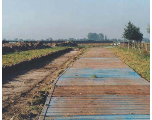
Abb. 2: Baggermatten, Vermeidung von Bodenverdichtung; Foto: Fa. Feldwisch, Bergisch Gladbach
