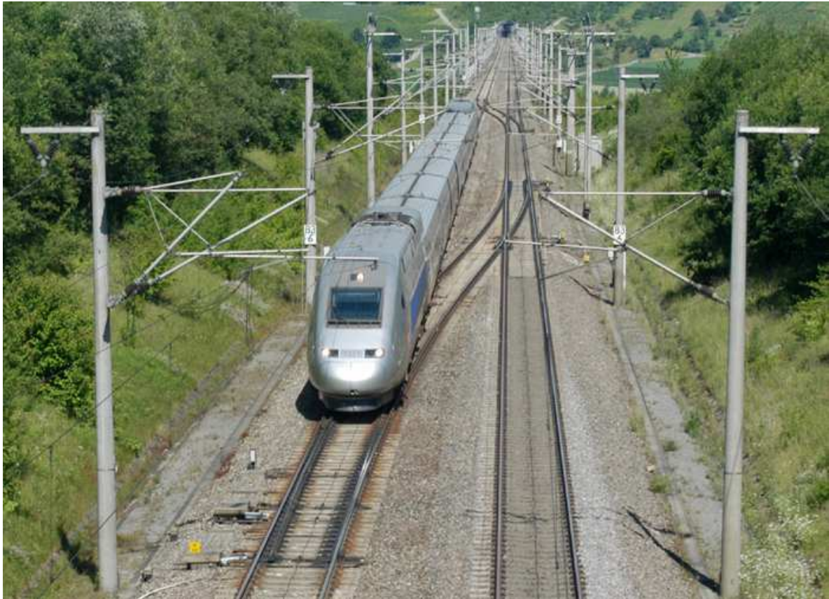
Abbildung 53 Erscheinungsbild neuzeitlicher Schieneninfrastruktur
